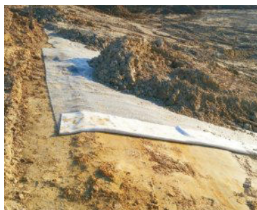
Überlappung Bentonitmatte
