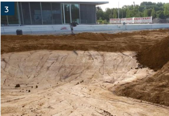
Nach der Verdichtung von ÖkoPond (gelbe Färbung) ist eine Auflast mit einem geeigneten humusfreien Schüttmaterial (braune Färbung) vollflächig, von min. 20 - 30 cm aufzubringen. Eine Verdichtung erfolgt hier nicht.
